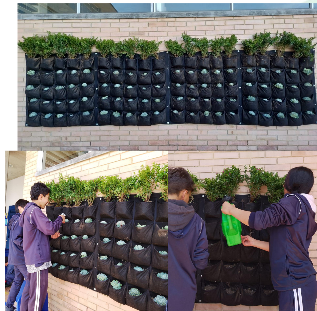
Construcción de jardines verticales
