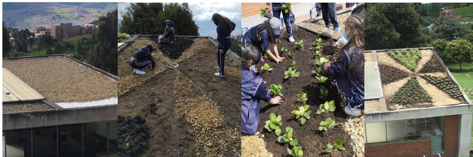
Construcción de Techos verdes
